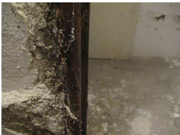
Foto č.11 – koroze kovových zárubní vlivem vysoké vnitřní relativní vlhkosti
