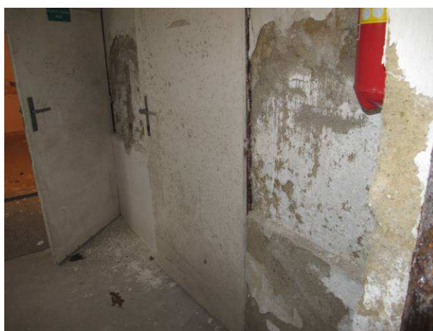
Foto č.16 – výskyt plísní na dřevěných prvcích v suterénu vlivem vysoké vnitřní relativní vlhkosti
