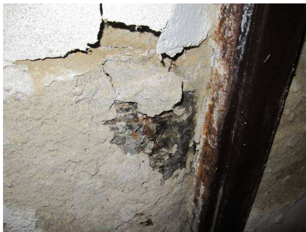
Foto č.18 – charakter provedení dodatečné soklové části po obvodu všech místností suterénu
