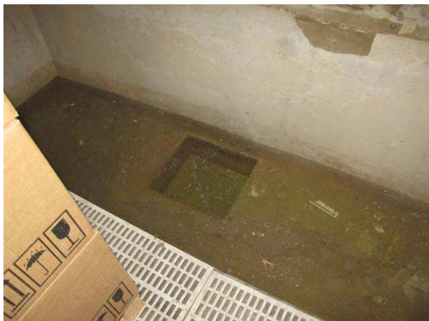
Foto č.13 – vysoká hladina spodní vody v suterénním prostoru objektu
