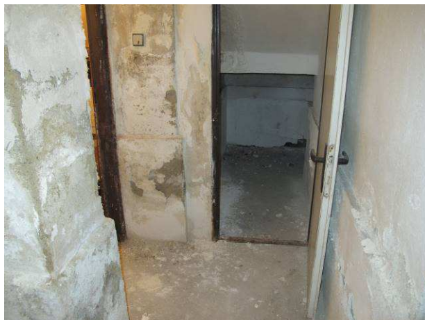
Foto č.8 – degradace omítkových systémů v plném rozsahu suterénu se solnými výkvěty
