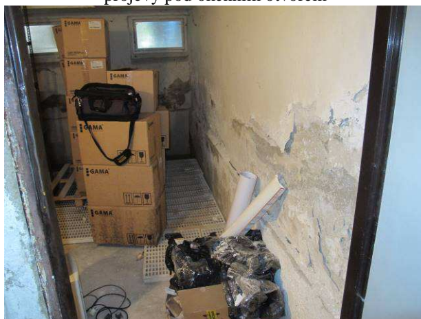
Foto č.12 – celková degradace povrchových úprav vlivem vztlínající zemní vlhkosti
