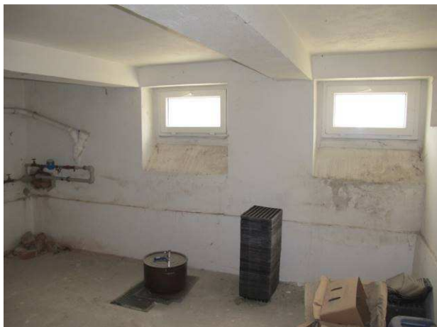
Foto č.19 – suterénní prostor budoucího výukového pracoviště půdní biologie s minimálními projevy vlhkosti na obvodových stěnách
