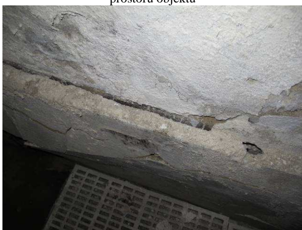
Foto č.15 – v minulosti provedený sokl po obvodu pro eliminaci vizuálního vzhledu vlivem vztlínající zemní vlhkosti
