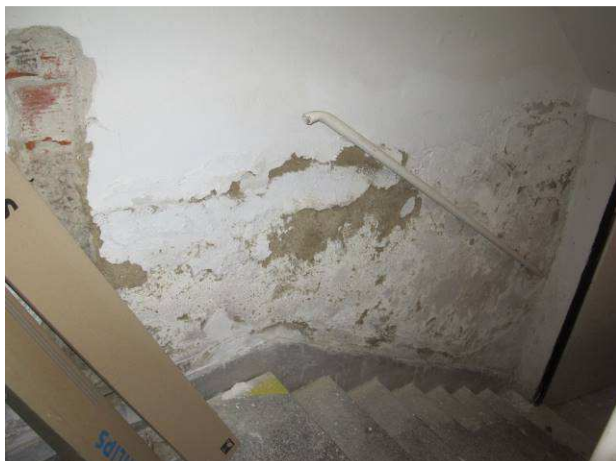
Foto č.7 – pohled na vstupní schodiště do suterénu s výraznými projevy vlhkosti
