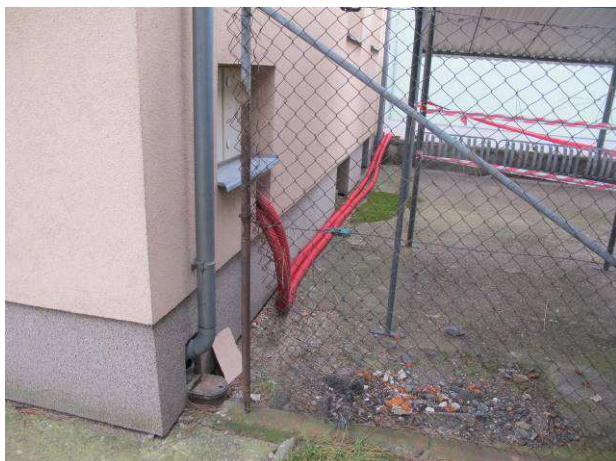
Foto č.3 – dešťové svody jsou osazeny lapači nečistot
