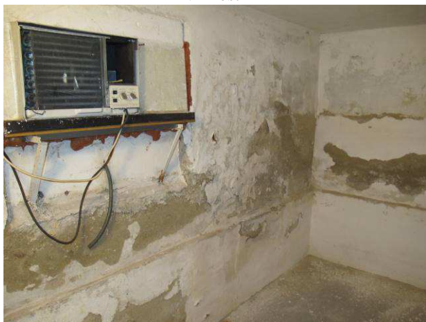
Foto č.17 – destrukce povrchů v plném rozsahu suterénních prostor objektu
