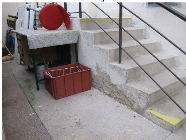
Foto č.6 – vstupní schodiště na jižní straně s vlhkostními projevy
