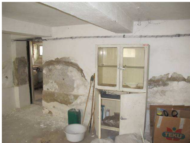
Foto č.20 – pohled na vnitřní stěnu v tomto prostoru s viditelnými vlhkostními projevy prakticky v plném rozsahu
